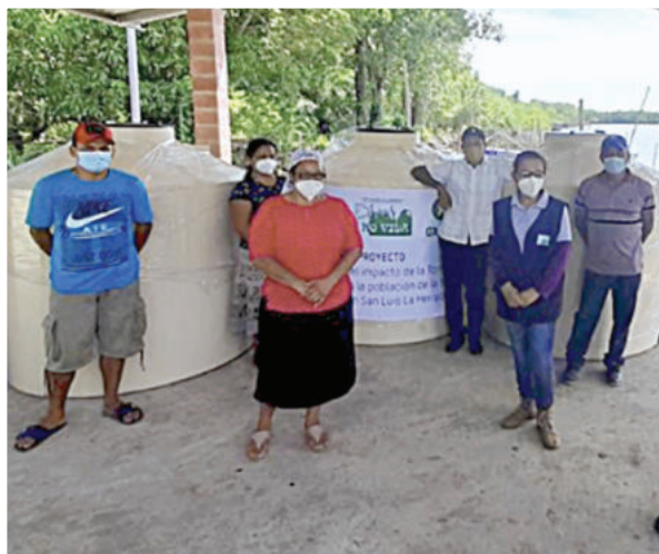
En las comunidades La Hacienda, El Ranchón y Quislua de la Isla de La Calzada, se instaló en puntos clave y colectivos de las comunidades 3 tanques de almacenamiento de agua para recolección de agua lluvia con su proceso de desinfección.
