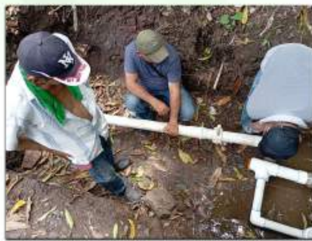
5 mejoras de infraestructura de acceso al agua en espacios públicos comunitarios con dificultades en el suministro de agua Cabañas – Cuscatlán.
